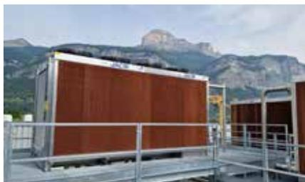
Compresseur Freecooling (refroidissement avec de l'air extérieur)
